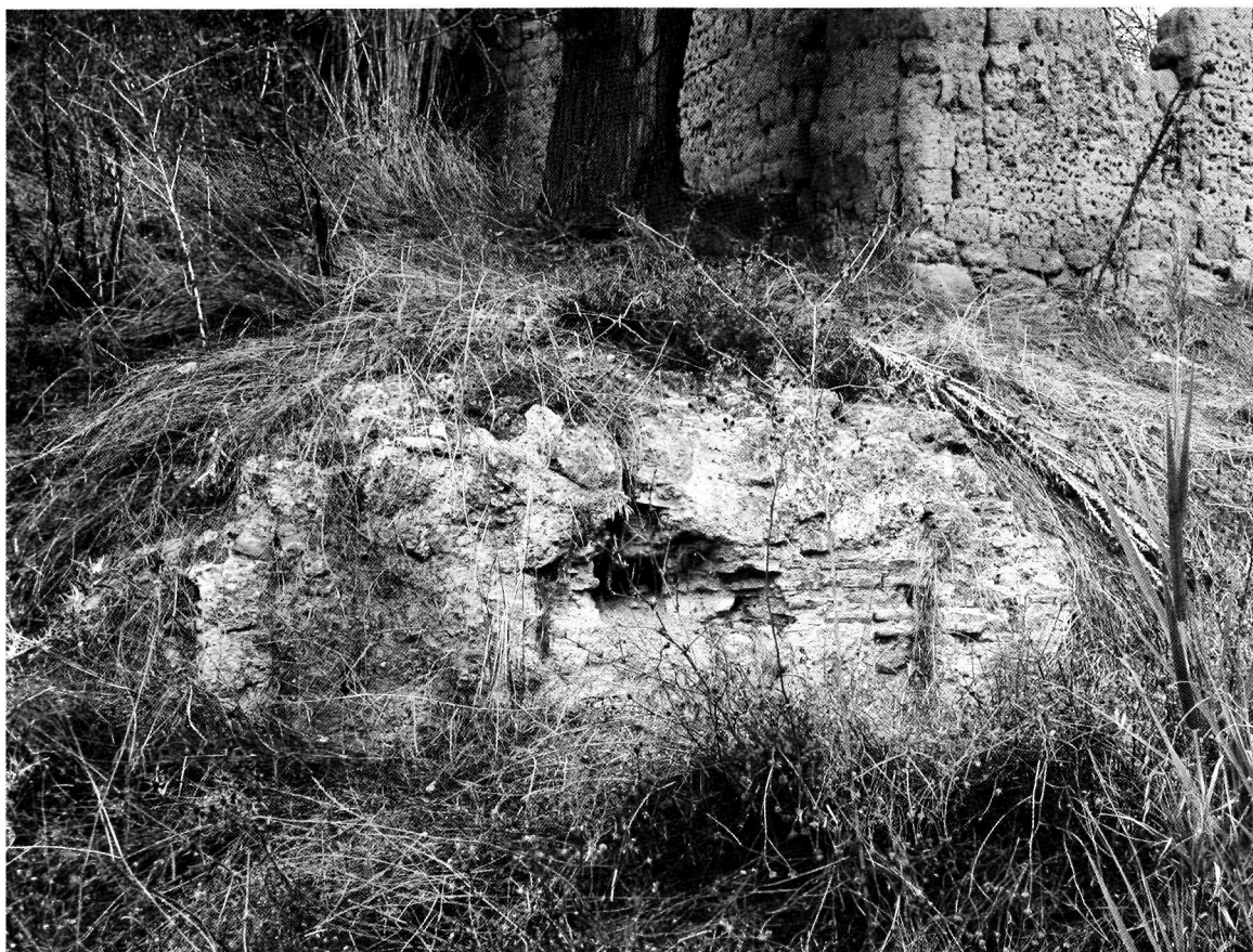
Fig. 9 - Mavrendi (Marmara). Resti di struttura in mattoni
