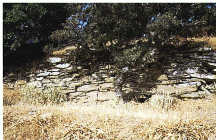
Εικ. 22 Αναλλήματικός τοίχος ανδρήρου καλλιέργειας στη θέση Χούγλι. Πρόκειται για τον τοίχο του ανδρήρου που δένει με τον τοίχο της περιφέρειας του πύργου.
