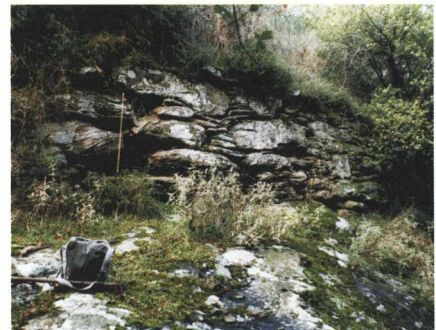
Εικ. 20-21 Τοιχοδομία των ανδρών καλλιέργειας στην κοιλάδα της Λουτριανής.
