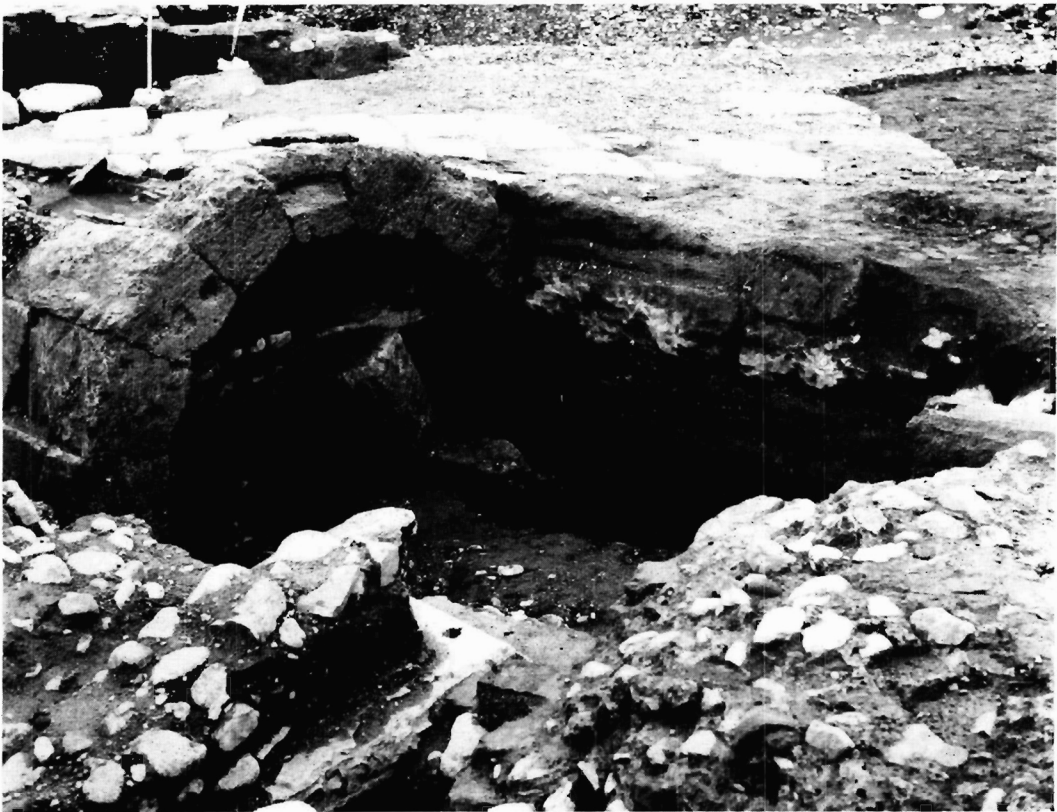
Εικόνα 8, 9. Πάτρα, μονότοξη παλιότερη γέφυρα.
