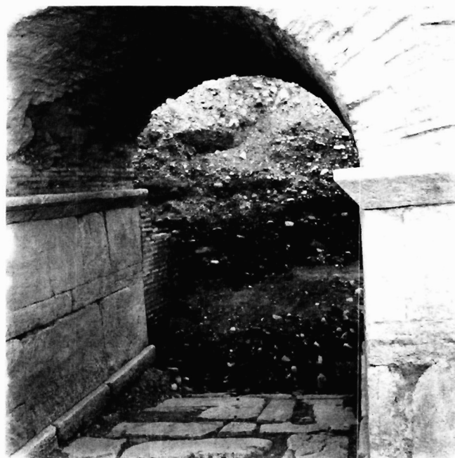
Εικόνα 5, 6, 7. Πάτρα. "Αποψη γέφυρας.
